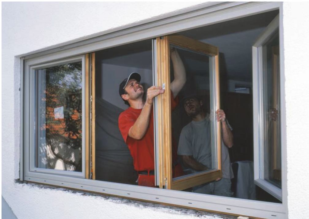
Einbau neuer Fenster.
