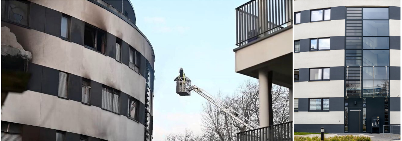
Beim Großbrand in Essen sorgten die geöffneten Lamellenfenster für ein rauchfreies Treppenhaus. Rettungs- und Fluchtwege wurden somit begehbar und die Evakuierung konnte problemlos erfolgen.
